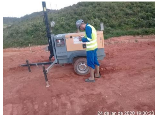
Foto 133 – Inspeção em torre de iluminação. (Data:24/01/20)
