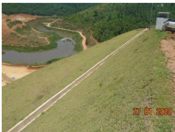
Foto 252 – Drenagem permanente no talude de corte da margem direita. (Data:27/01/20)
