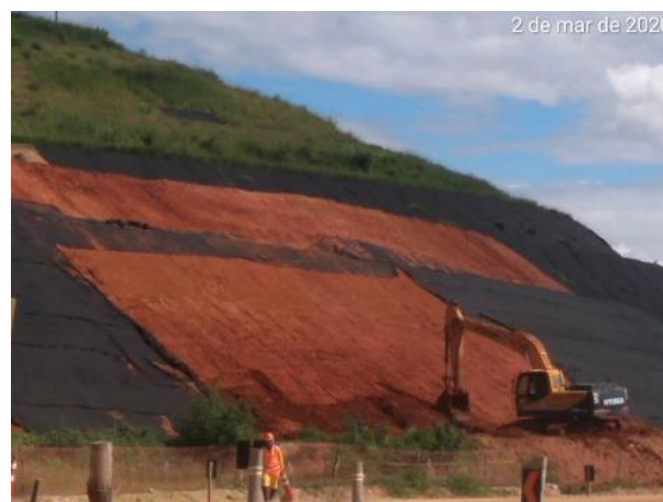
Foto 285 –Conformação de talude após erosões de chuva na margem direita. (Data:02/03/20)
