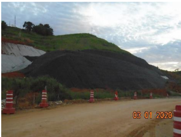
Foto 206– Sinalização implantada na estrada municipal de Pedreira. (Data:03/01/20)
