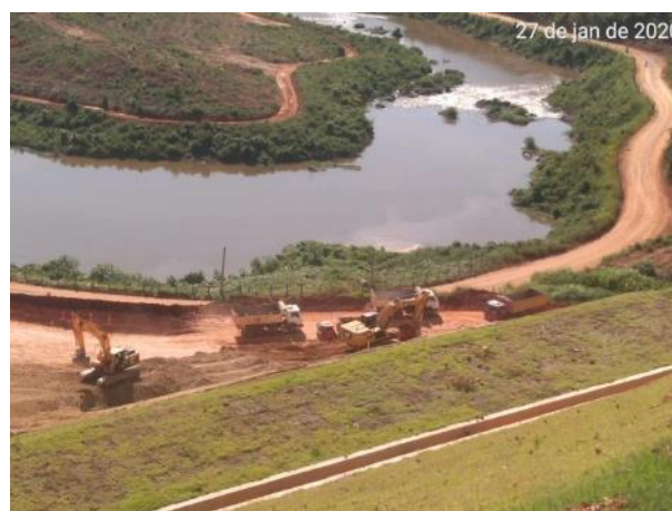
Foto 407 – Movimentação de terra próximo ao eixo do projeto, margem direita. (Data:27/01/20)
