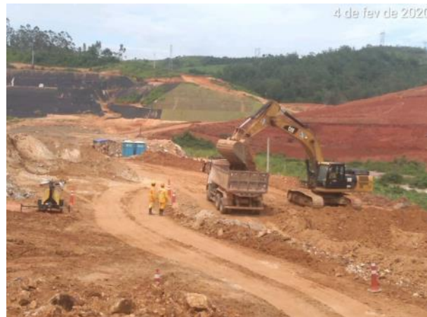
Foto 411 – Movimentação de terra na margem esquerda. (Data:04/02/20)
