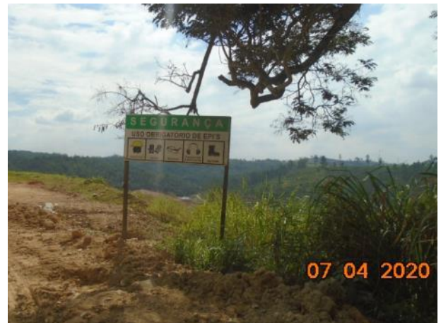
Foto 239 – Sinalização para o uso obrigatório de EPI'S na área do canteiro operacional. (Data:07/04/20)
