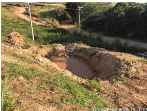
Foto 264 – Drenagem provisória do bota fora VII. (Data:23/04/20)
