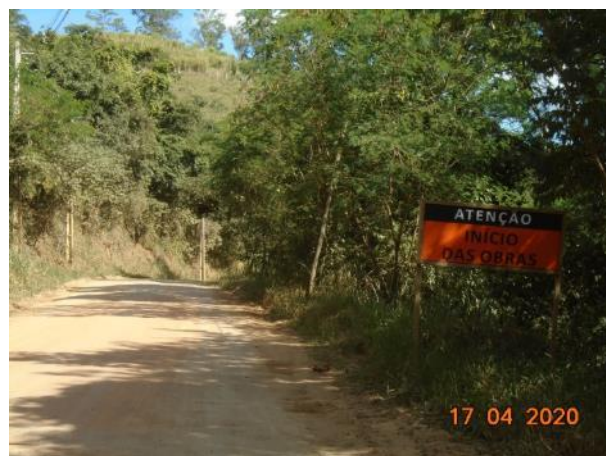
Foto 223 – Sinalização na estrada municipal de Pedreira sobre início do trecho das obras. (Data:17/04/20)
