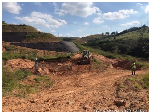
Foto 271 – Manutenção no bota-fora IV – margem direita. (Data:16/04/20)
