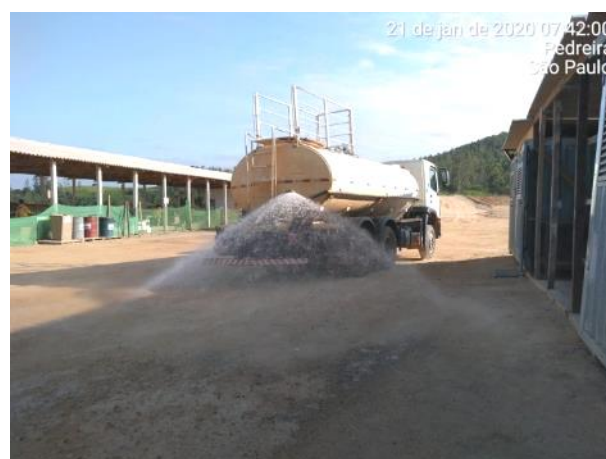
Foto 343 – Umectação nas vias internas – canteiro operacional. (Data:21/01/20)
