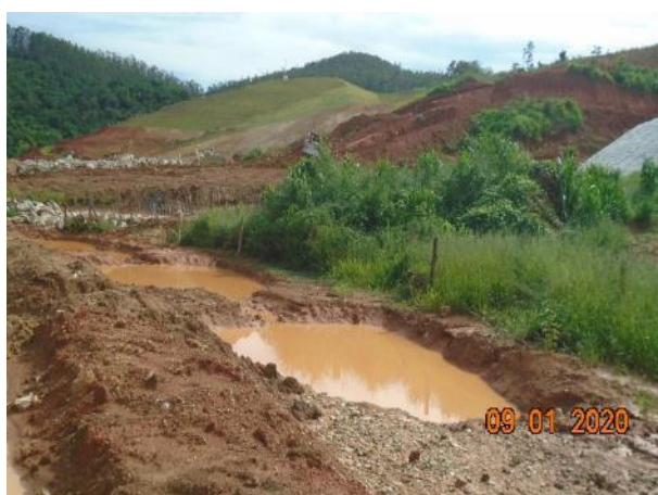
Foto 247 Sistema de contenção através da sequência de 3 cacimbas, margem direita. (Data:09/01/20).
