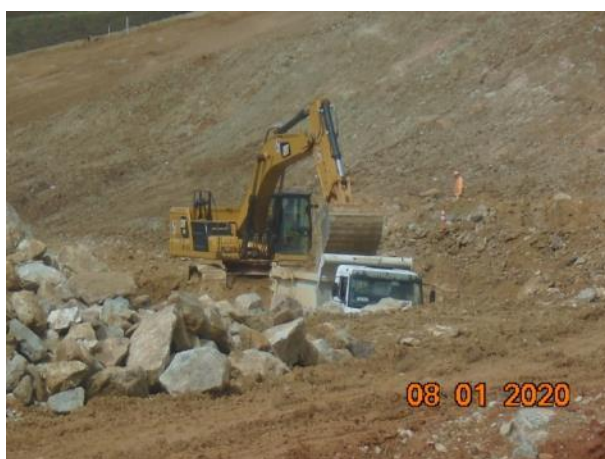
Foto 394 – Movimentação de terra na área do eixo. (Data:08/01/20)
