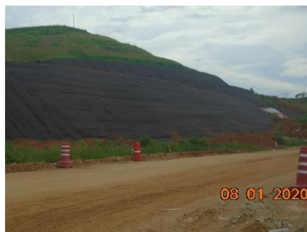
Foto 267 – Proteção com manta geotêxtil no talude do bota-espera da margem direita. (Data:13/01/20)
