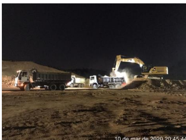
Foto 424 – Movimentação de terra na margem esquerda. (Data:10/03/20)
