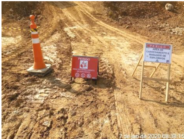
Foto 156 – Placa informativa sobre o carregamento e manuseio de explosivos. (Data:07/01/20)
