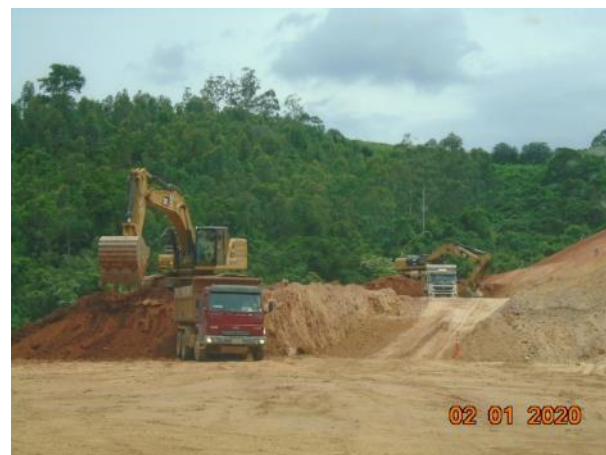
Foto 393 – Movimentação de terra no bota fora VII. (Data:02/01/20)
