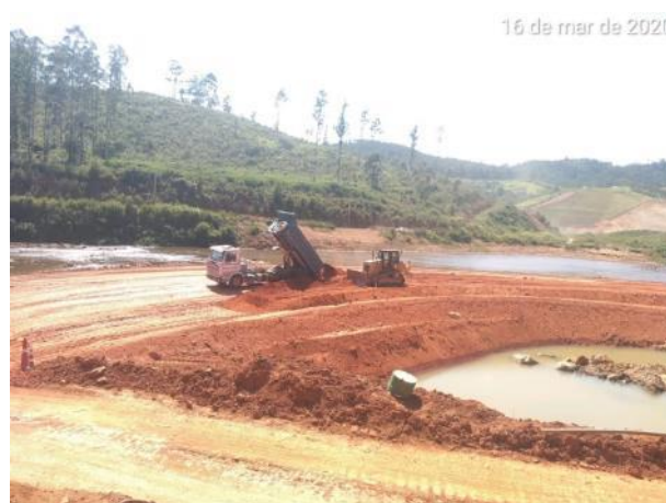
Foto 427 – Movimentação de terra enseadeira M0. (Data:16/03/20)
