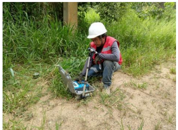
Foto 161 – Sismógrafo para registro de vibração terrestre e pressão acústica. (Data:22/01/20)
