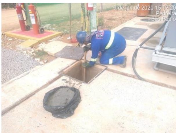
Foto 308 – Limpeza da caixa SÃO 1. (Data:09/01/20)
