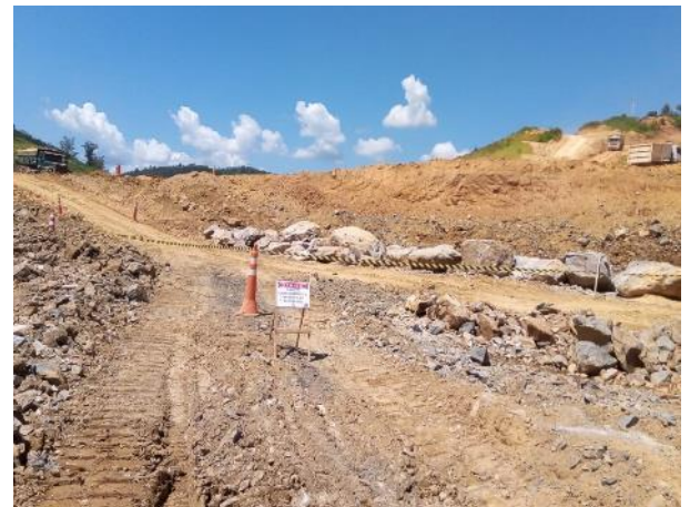
Foto 165 – Isolamento de área durante carregamento de explosivos. (Data:12/03/20)
