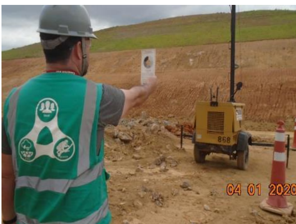
Foto 362– Inspeção de fumaça preta em torre de iluminação – margem esquerda. (Data:02/03/20)
