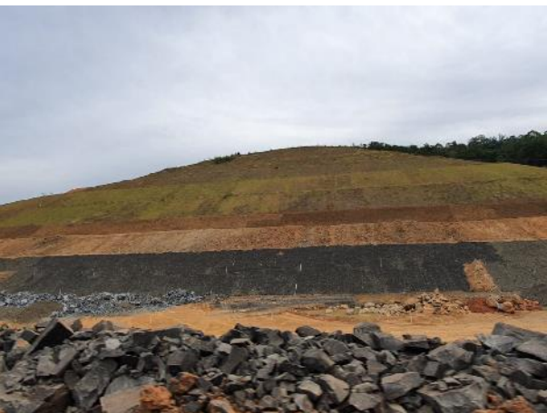
Foto 292 — Talude de corte gramado e enrocamento no canal de desvio – Margem esquerda. (Data:14/04/20)
