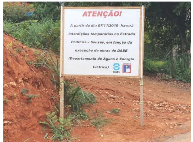
Foto 159 –Placa informativa sobre as atividades de desmonte de rocha na estrada municipal de Pedreira. (Data:10/01/20)
