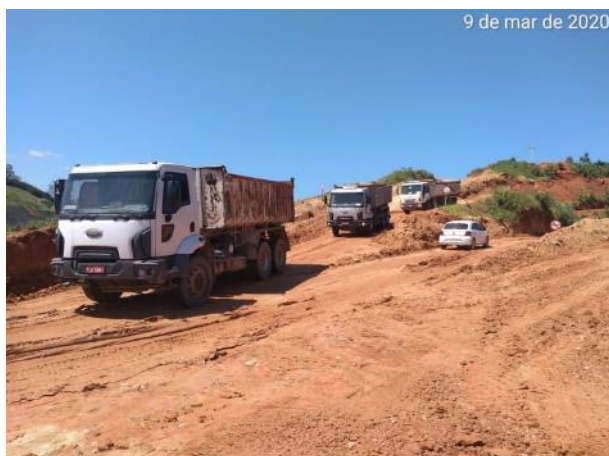
Foto 422 – Movimentação de terra na margem esquerda. (Data:09/03/20)
