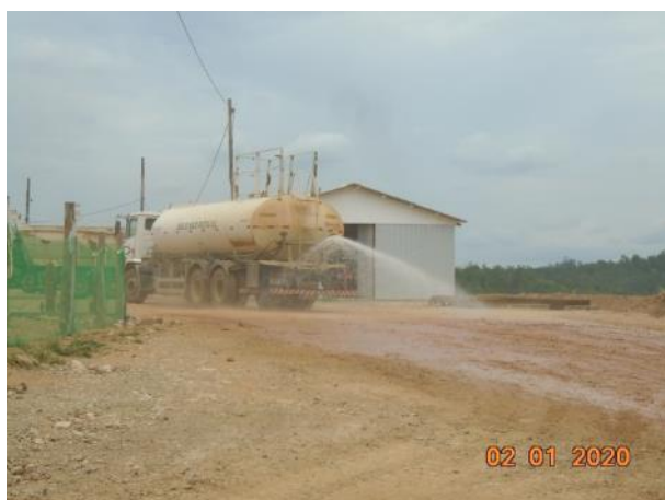
Foto 338 – Umectação nas vias internas – canteiro operacional. (Data:02/01/20)
