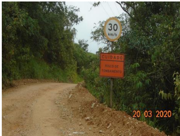
Foto 238 – Sinalização sobre risco de tombamento e velocidade máxima permitida. (Data:20/03/20)
