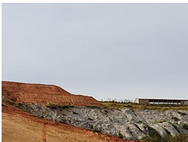
Foto 300 – Bota-fora II – Margem Direita. (Data:30/04/20)
