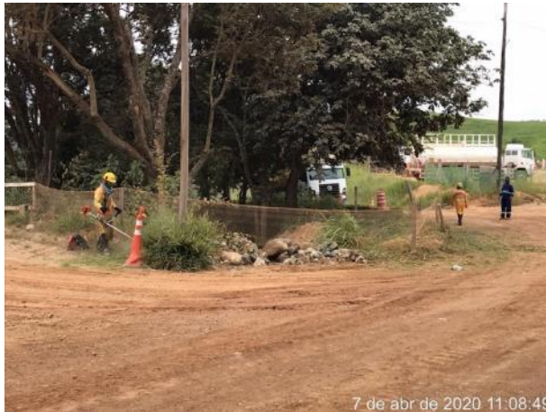
Foto 110– Manutenção na área do canteiro operacional. (Data:07/04/20)
