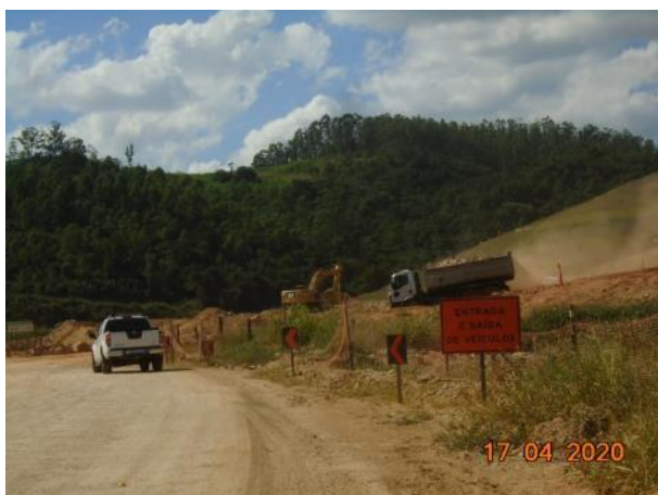
Foto 222 – Sinalização de entrada e saída de veículos no acesso para margem direita. (Data:17/04/20)
