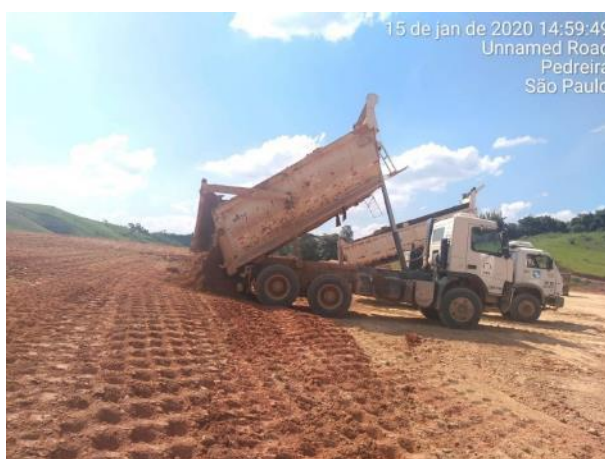
Foto 396 – Movimentação de terra no bota fora VII. (Data:15/01/20)
