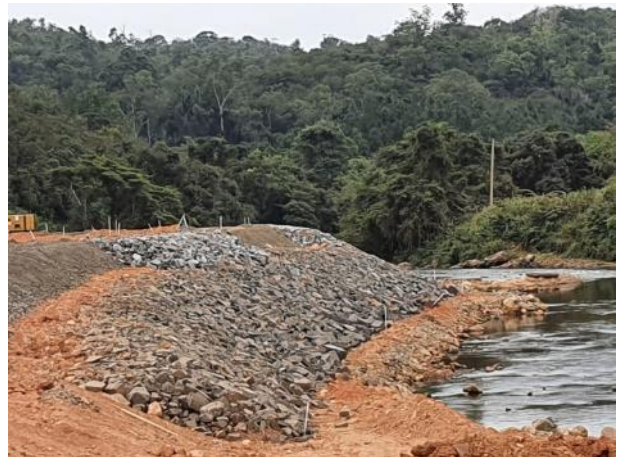
Foto 291 — Enrocamento na enseadeira J0. (Data:14/04/20)
