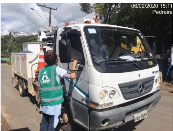
Foto 198 –Comunicado para a população sobre a atividade de desmonte de rocha. (Data:06/02/20)
