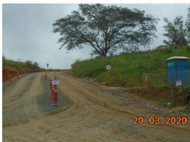
Foto 236 – Sinalização interna no acesso para o canteiro operacional. (Data:20/03/20)
