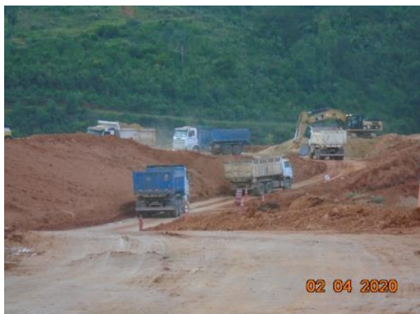
Foto 428 – Movimentação de terra na margem esquerda. (Data:02/04/20)
