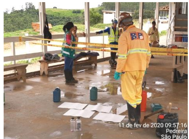
Foto 61 – Registro de colaborador contendo pequeno princípio de incêndio. (Data:11/02/20)
