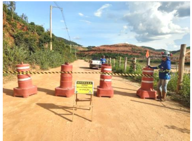
Foto 157 – Bloqueio temporário durante atividade de desmonte de rochas na estrada municipal de Pedreira. (Data:07/01/20)
