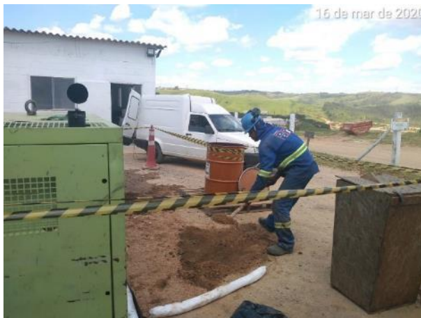
Foto 84 – Atendimento a emergência ambiental devido a vazamento de diesel do gerador. (Data:16/03/2020)
