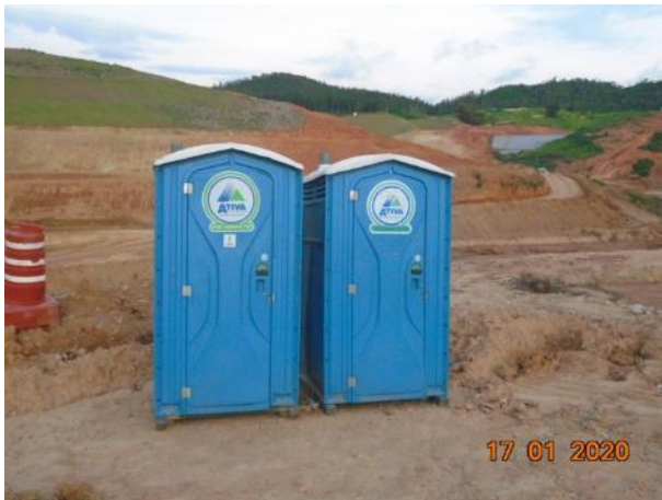
Foto 318 – Banheiros químicos instalados na margem esquerda. (Data:17/01/20)
