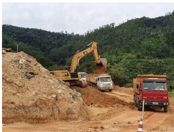
Foto 433 – Movimentação de terra margem direita, na execução do acesso MD03. (Data:13/02/20)
