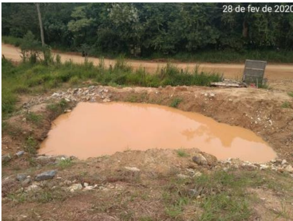
Foto 258 – Drenagem provisória a jusante do bota fora VII, retendo a água de chuva. (Data:28/02/20)
