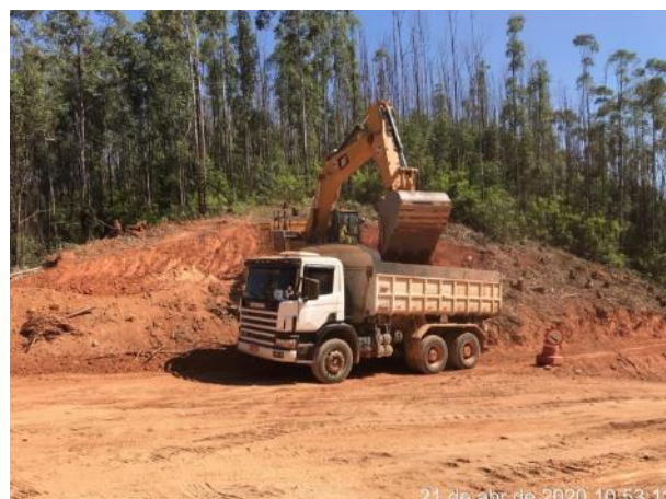
Foto 435 – Movimentação de terra margem direita execução do acesso MD03. (Data:21/04/20)
