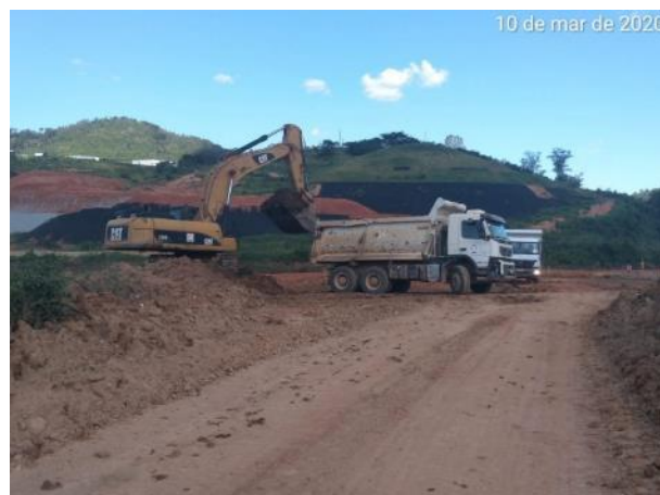
Foto 423 – Movimentação de terra margem esquerda. (Data:13/02/20)
