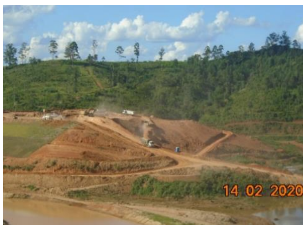
Foto 416 – Movimentação de terra na margem esquerda. (Data:14/02/20)
