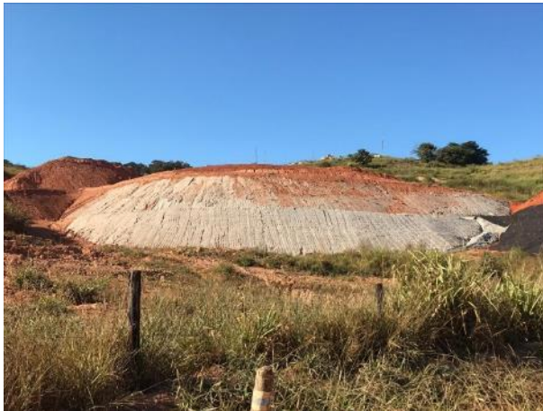
Foto 306 – Bota-espera espaldar – Margem Direita. (Data:30/04/20)
