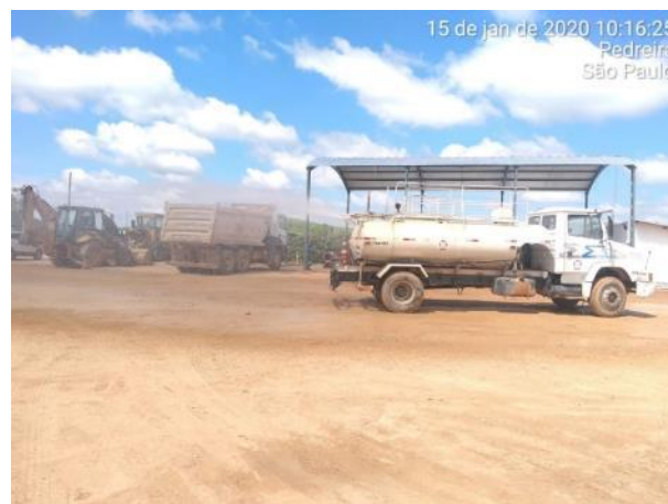
Foto 341 – Umectação nas vias internas, pátio da mecânica. (Data:15/01/20)
