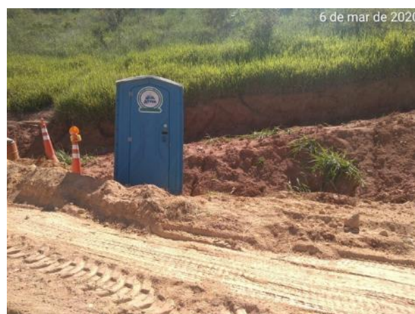
Foto 325 – Banheiro químico instalado na frente de serviço (Data:06/03/20)
