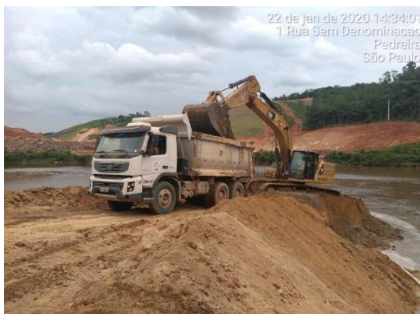
Foto 404 – Movimentação de terra na ensacadeira J0, margem direita. (Data:22/01/20)
