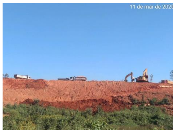
Foto 425 – Movimentação de terra margem esquerda. (Data:11/03/20)
