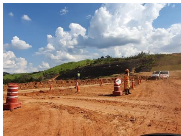
Foto 235 – Sinalização interna na margem esquerda. (Data:19/03/20)
