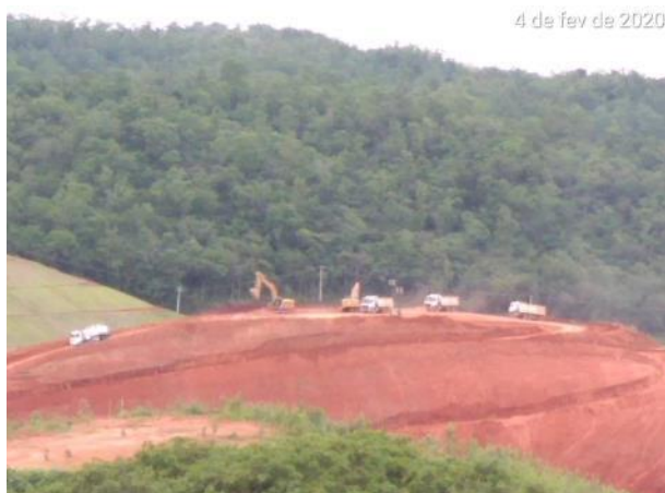
Foto 410 – Movimentação de terra na margem esquerda. (Data:04/02/20)
