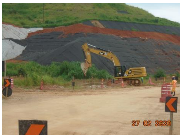
Foto 282 – Limpeza de cacimba na margem direita próximo a área do eixo. (Data:27/02/20)
