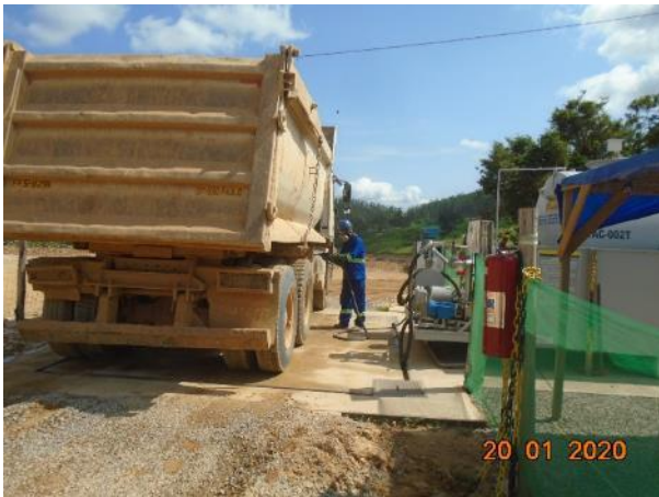
Foto 64– Abastecimento de caminhão basculante. (Data:20/01/20)
