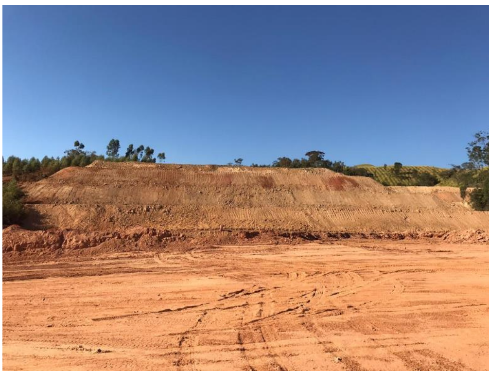
Foto 437 – Bota fora II – Margem Esquerda. (Data:30/04/20)
