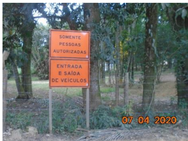
Foto 220 – Sinalização para pessoas autorizadas e saída de veículos no acesso para o canteiro administrativo. (Data:07/04/20)
