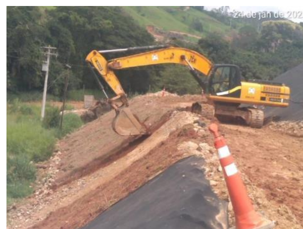
Foto 275 – Conformação de talude e aplicação de solo vegetal no bota fora VII. (Data:24/01/20)
