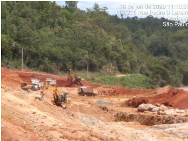
Foto 400 – Movimentação de terra na área de desvio do rio na margem esquerda. (Data:18/01/20)
