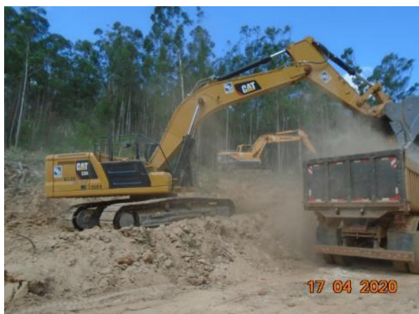
Foto 434 – Movimentação de terra na margem direita execução do acesso MD03. (Data:17/04/20)
