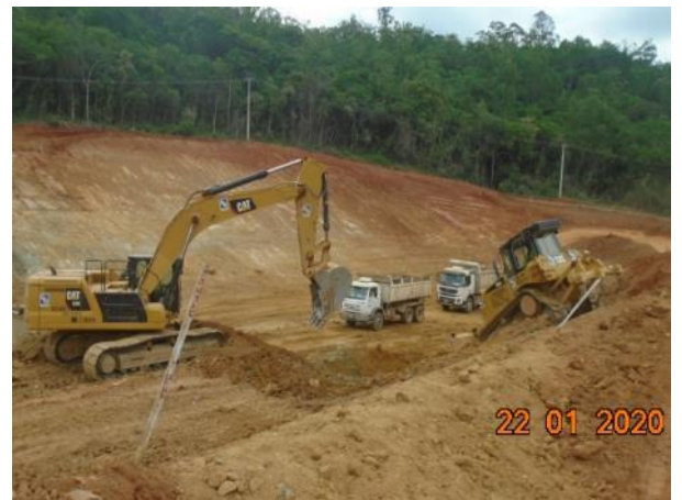
Foto 403 –Movimentação de terra na área do desvio do rio, margem esquerda. (Data:22/01/20)
