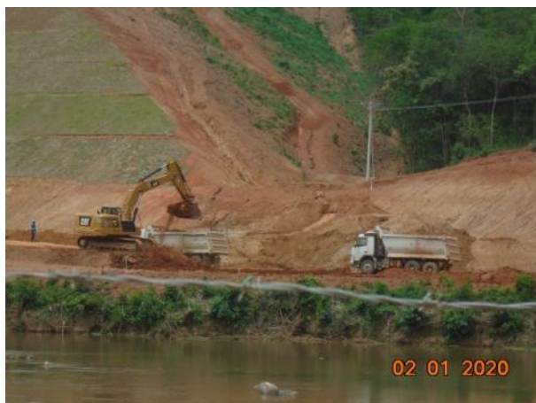
Foto 392 – Movimentação de terra na margem esquerda. (Data:02/01/20)
