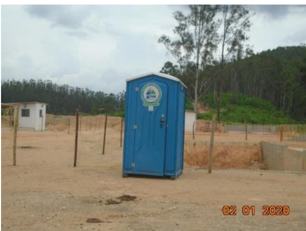
Foto 316 – Banheiro químico instalados na área do canteiro operacional. (Data:02/01/20)
