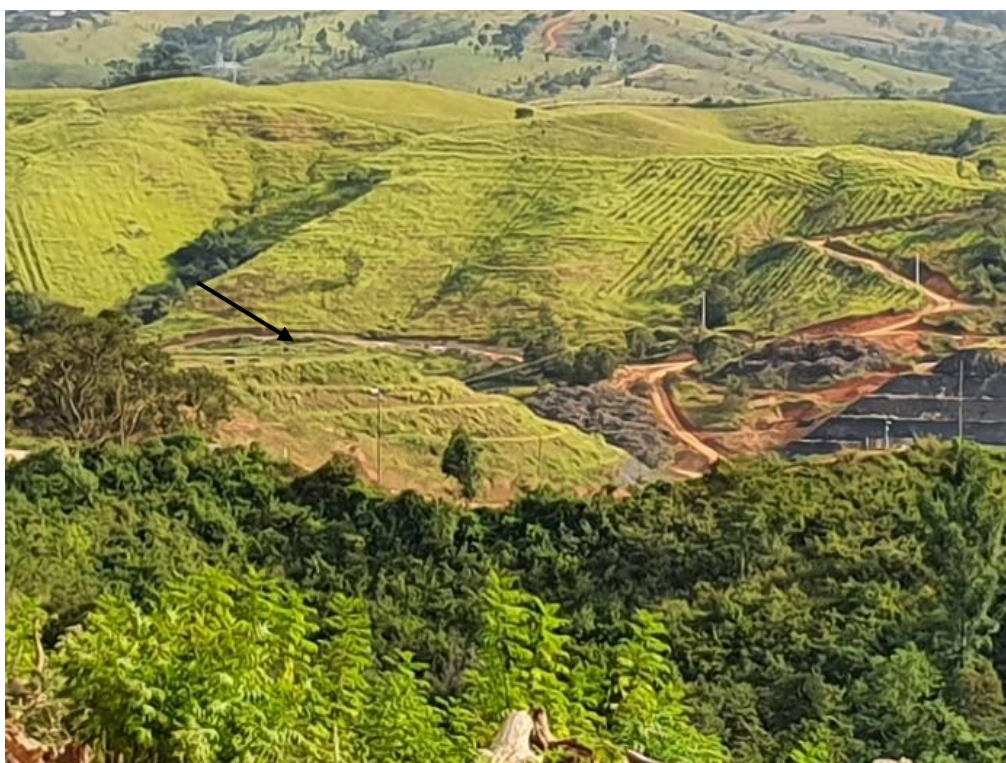
Foto 438 – Bota fora I – Margem Direita. (Data:30/04/20)
