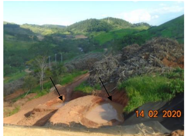
Foto 257 – Drenagem provisória através de cacimba no pátio de galhadas na margem esquerda. (Data:14/02/20)
