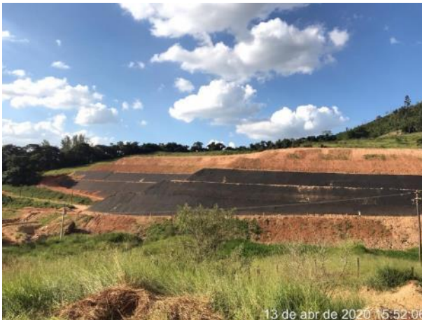
Foto 290 — Bota-fora VII com manta geotêxtil para proteção do talude. (Data:13/04/20)
