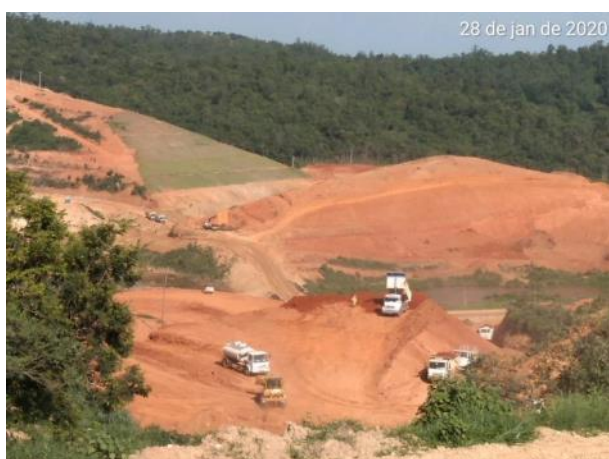
Foto 408 – Movimentação de terra próximo ao eixo do projeto, margem esquerda. (Data:28/01/20)
