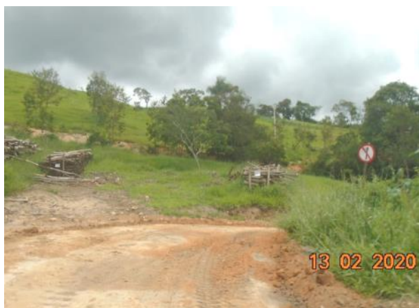
Foto 232 – Sinalização de sentido proibido em caminho de serviço na margem esquerda. (Data:13/02/20)
