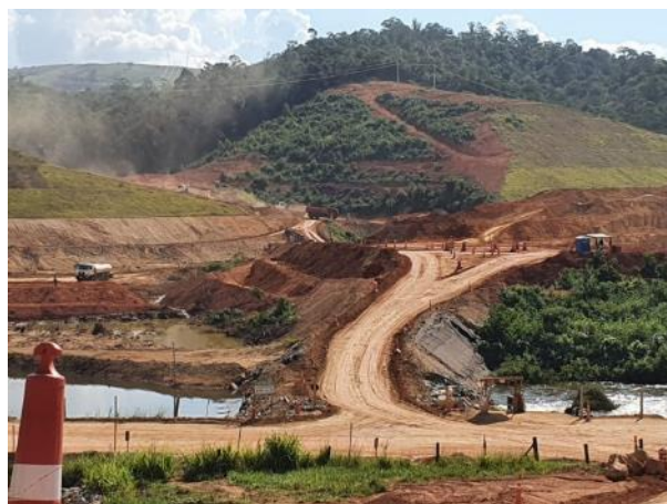
Foto 429 – Movimentação de terra na margem esquerda do projeto. (Data:06/04/20)
