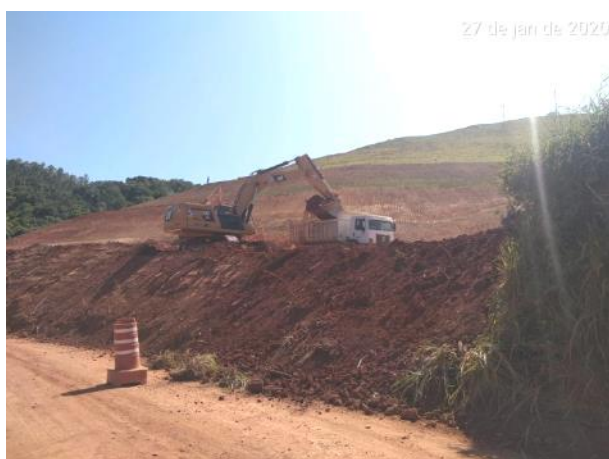
Foto 406 – Movimentação de terra próximo ao eixo do projeto. (Data:27/01/20)
