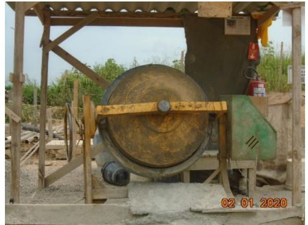
Foto 63– Betoneira no canteiro operacional. (Data:02/01/20)
