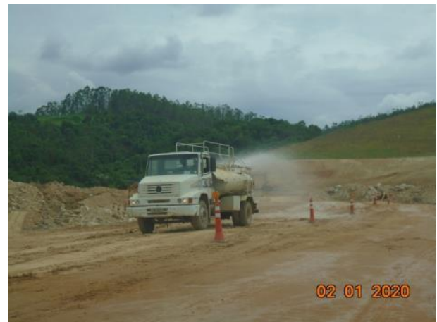
Foto 337 – Umectação nas vias internas – margem direita. (Data:02/01/20)
