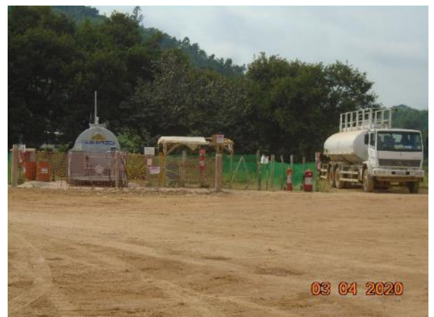
Foto 73 – Área de abastecimento, sinalizada e isolada. (Data:03/04/20)
