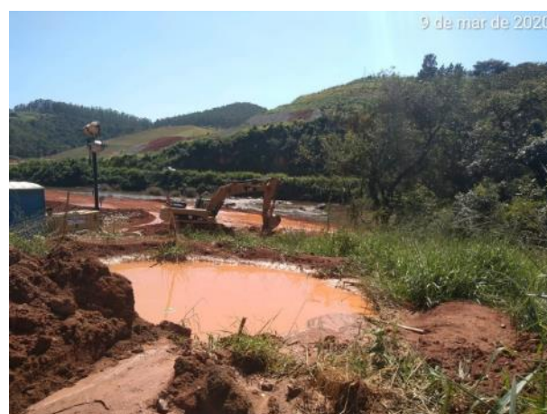
Foto 287 –Limpeza de cacimba na margem esquerda. (Data:09/03/20)
