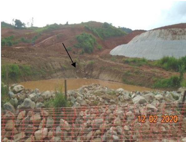
Foto 256 – Drenagem provisória através de cacimba na margem direita, próximo à área do eixo. (Data:13/01/20)
