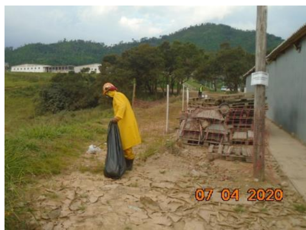
Foto 109 – Limpeza na área do almoxarifado, canteiro operacional. (Data:07/04/20)
