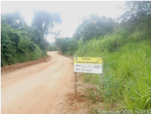
Foto 162 – Placa informativa sobre a atividade de desmonte de rocha na estrada municipal de Pedreira. (Data:06/02/20)
