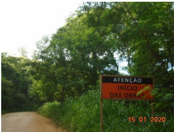
Foto 208– Sinalização de início de obra. (Data:15/01/20)
