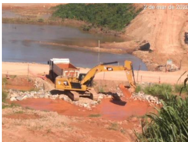
Foto 284 –Limpeza de cacimba na margem direita próximo a área do eixo. (Data:02/03/20)
