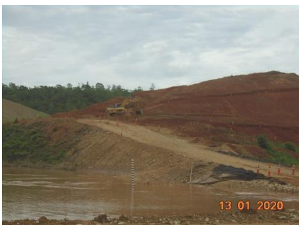
Foto 272 – Limpeza de cacimba na margem esquerda. (Data:13/01/20)
