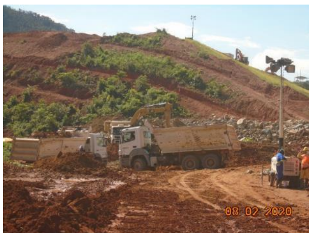
Foto 412 – Movimentação de terra na margem esquerda. (Data:08/02/20)
