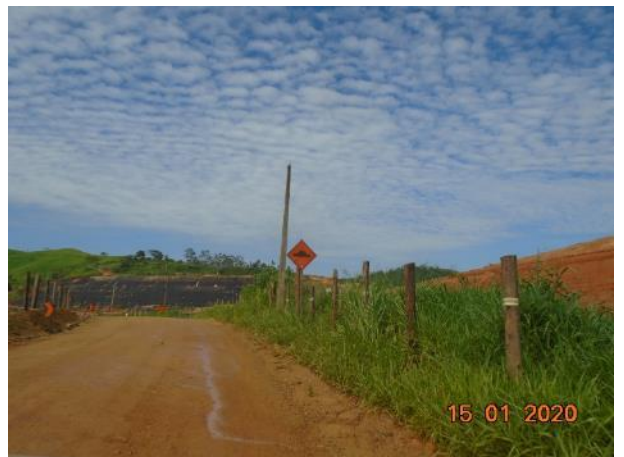
Foto 209– Sinalização na estrada municipal de Pedreira. (Data:15/01/20)
