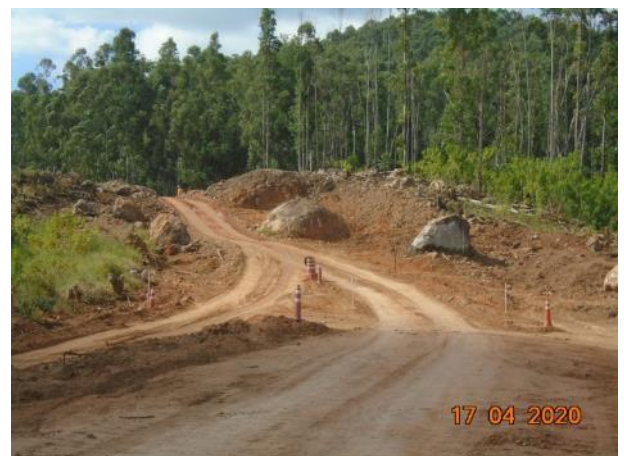
Foto 243 – Sinalização no caminho de serviço da MD03. (Data:17/04/20)
