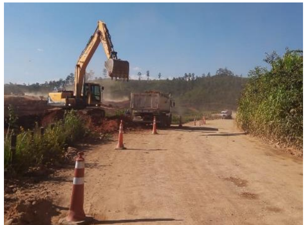
Foto 215 – Sinalização para execução de atividade próxima a estrada municipal de Pedreira. (Data:13/03/20)
