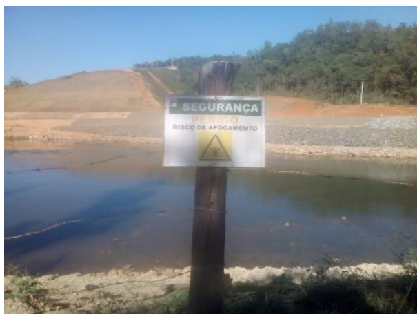
Foto 242 – Sinalização sobre risco de afogamento no local. (Data:17/04/20)
