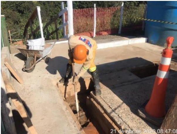
Foto 314 – Registro da caixa AS 2 na área da oficina mecânica no canteiro operacional. (Data:21/04/20)
