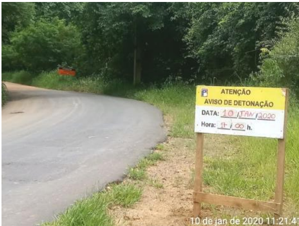
Foto 158 – Placa informativa sobre a atividade de desmonte de rocha na estrada municipal de Pedreira. (Data:10/01/20)
