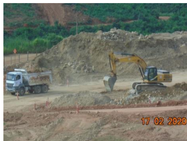
Foto 419 – Movimentação de terra na margem direita. (Data:17/02/20)
