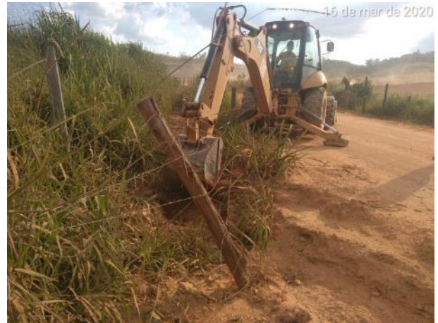
Foto 289 —Registro de limpeza de bueiro próximo a área do eixo. (Data:16/03/20)
