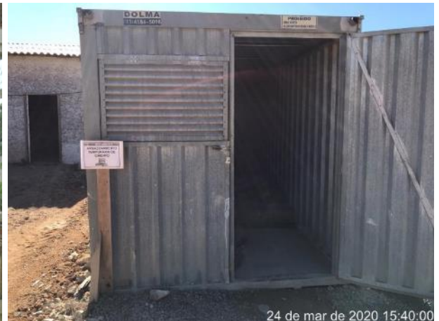
Foto 71 – Armazenamento de cimento no canteiro operacional. (Data:24/03/20)
