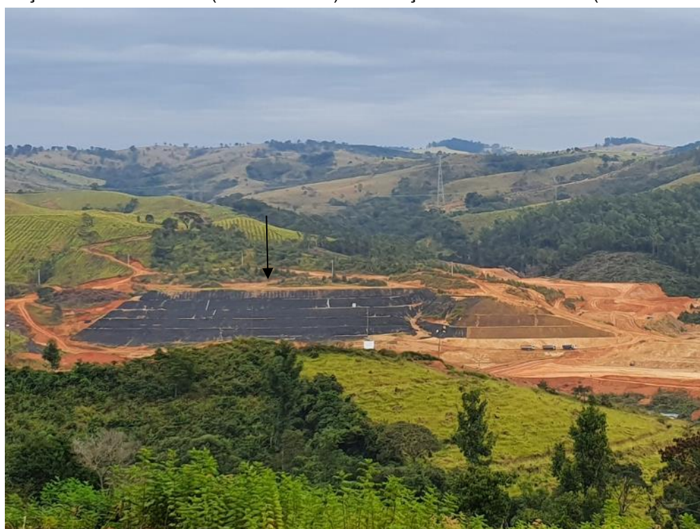
Foto 436 – Bota fora I Margem Esquerda. (Data:13/04/20)
