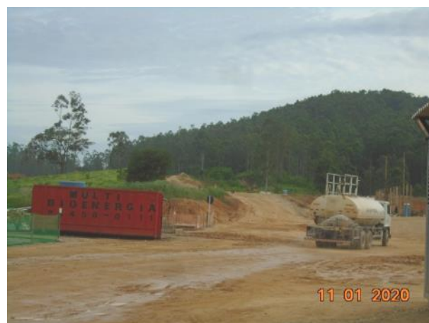
Foto 339 – Umectação nas vias internas – canteiro operacional. (Data:11/01/20)
