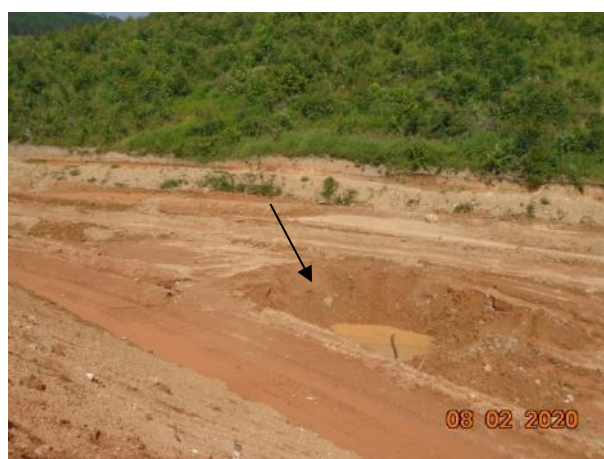
Foto 255 – Drenagem provisória através de cacimba na margem esquerda. (Data:08/02/20)
