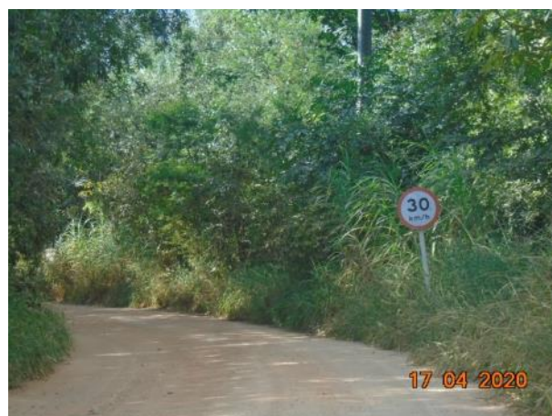
Foto 225 – Sinalização de limite máximo de velocidade no trecho, estrada Sousas-pedreira. (Data:17/04/20)
