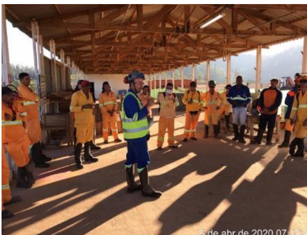
Foto 190– DDS sobre comportamento de risco: incidente ocorrido na obra. (Data:06/04/20)
