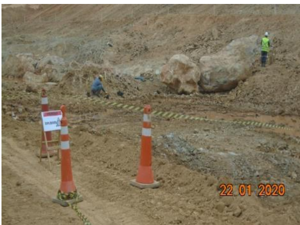
Foto 160 – Isolamento de área durante carregamento de explosivos. (Data:22/01/20)
