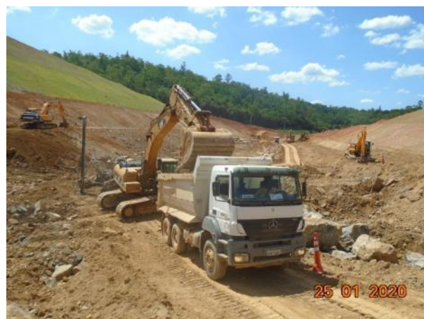
Foto 405 –Movimentação de terra próximo ao eixo do projeto. (Data:25/01/20)
