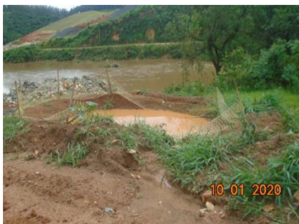
Foto 248 – Cacimba na margem esquerda, próxima a enseadeira M0, retendo água da chuva. (Data:10/01/20)
