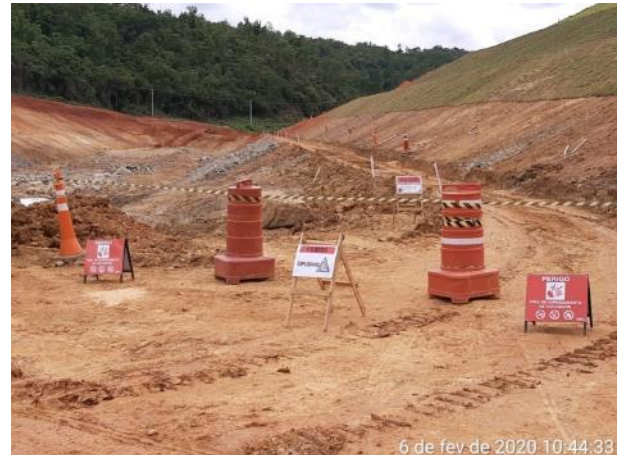
Foto 163 – Área isolada pós carregamento de explosivos. (Data:06/02/20)
