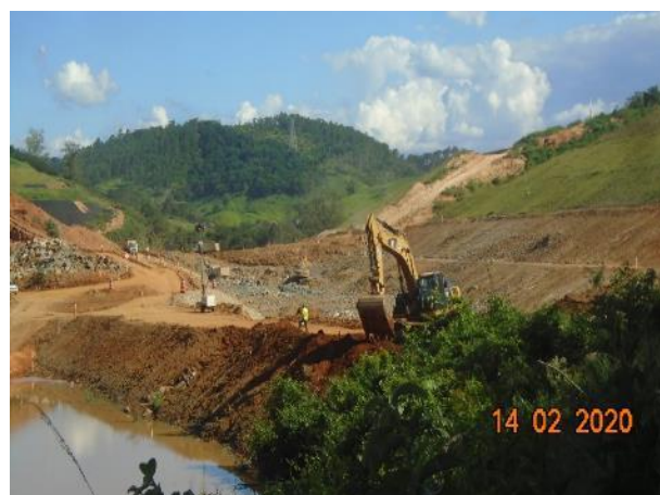
Foto 281 – Conformação de talude na margem esquerda após chuva. (Data:14/02/20)
