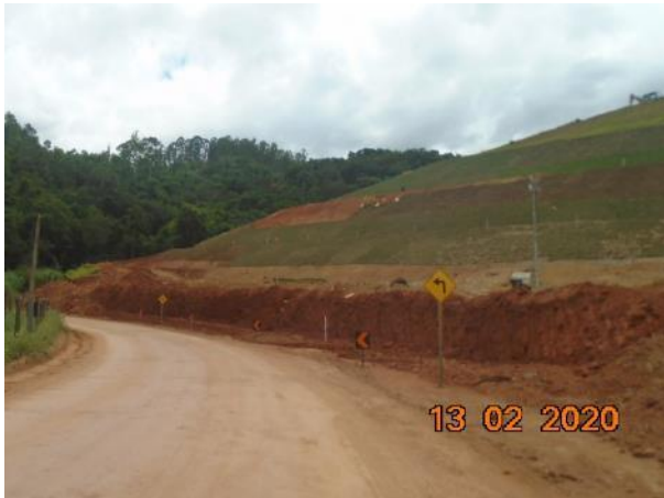
Foto 216 – Sinalização na estrada municipal de Pedreira para curva acentuada e balizadores. (Data:13/03/20)
