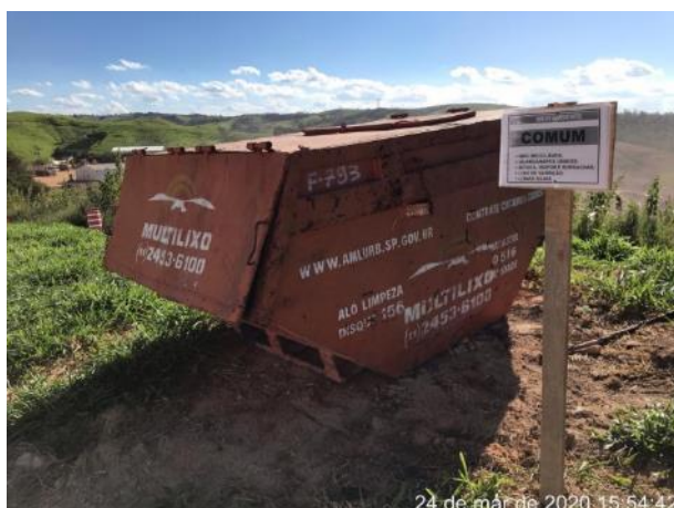
Foto 386 –Caçamba de resíduo comum no canteiro operacional. (Data:24/03/20)
