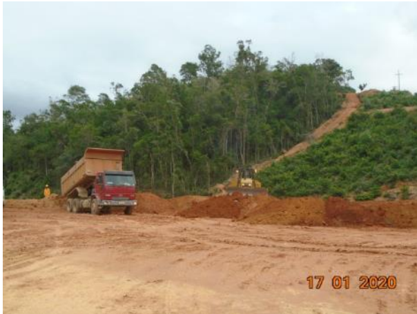
Foto 398 – Movimentação de terra no bota fora VII. (Data:17/01/20)
