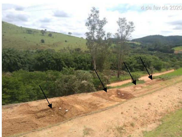
Foto 254 – Drenagem provisória implantada através de cacimbas no bota fora V. (Data:04/02/20)
