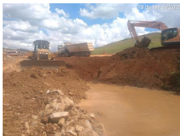
Foto 415 – Movimentação de terra ensecadeira J0, margem esquerda. (Data:13/02/20)
