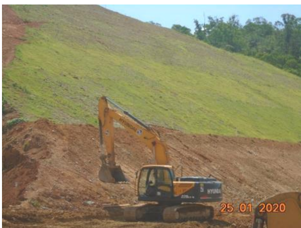
Foto 276 – Confirmação de talude de corte na margem direita, próximo ao eixo do projeto. (Data:25/01/20)
