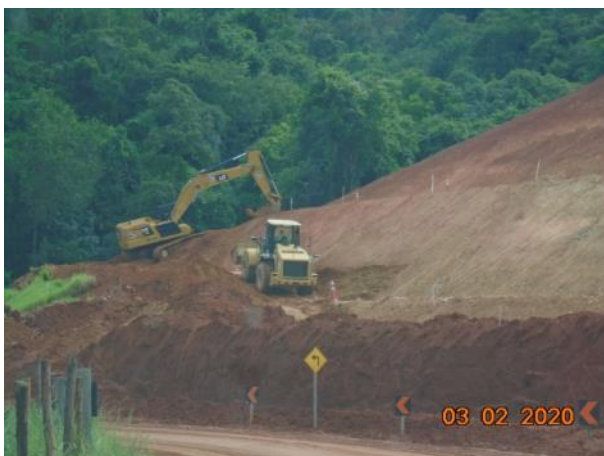
Foto 278 – Compactação de talude pós-chuvas na margem direita próximo a área do eixo. (Data:03/02/20)
