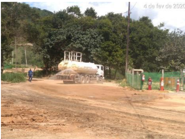
Foto 346 – Umectação nas vias internas – canteiro operacional. (Data:04/02/20)
