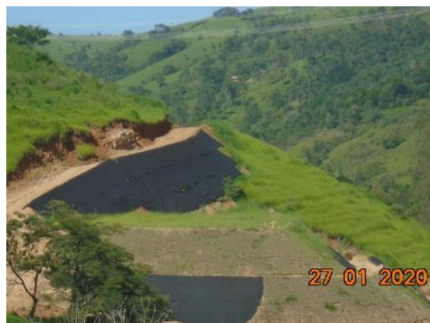
Foto 277 – Manta geotêxtil implantada no talude do bota fora IV – margem direita. (Data:27/01/20)
