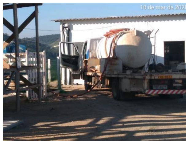
Foto 327 – Registro de retirada, limpeza e higienização do banheiro químico. (Data:10/03/20)
