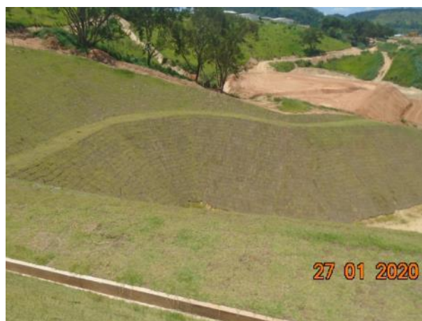
Foto 253 – Drenagem permanente no talude de corte da margem direita. (Data:27/01/20)
