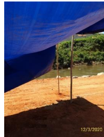
Foto 127 – Utilização de bambu para estrutura de apoio na frente de serviço (Data:12/03/20)
