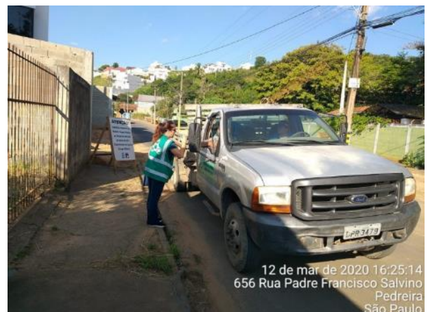
Foto 205 — Comunicado para a população sobre a atividade de desmonte de rocha. (Data:12/03/20)
