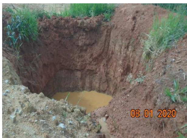
Foto 246 – Cacimba implantada no acesso para o canteiro operacional. (Data:09/01/20)
