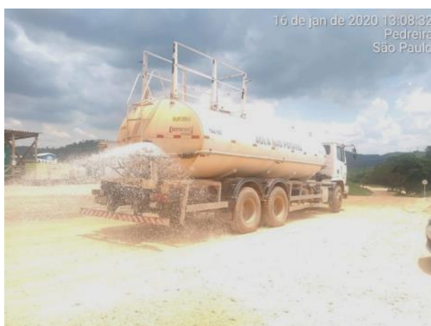
Foto 342 – Umectação nas vias internas – canteiro operacional. (Data:16/01/20)
