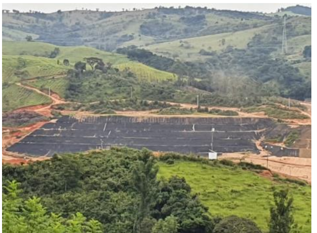
Foto 293 — Bota-fora I coberto por manta geotêxtil – Margem esquerda. (Data:14/04/20)
