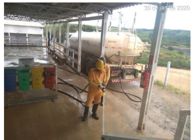
Foto 97 – Limpeza da área de vivência no canteiro operacional. (Data:30/01/20)
