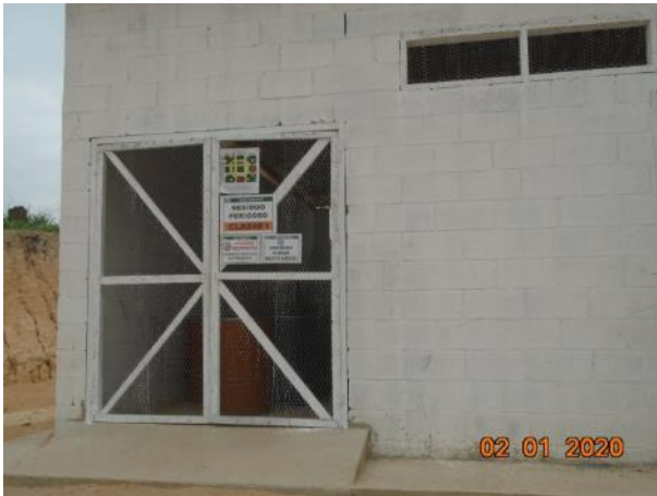
Foto 62– Baía para armazenamento de resíduos perigosos. (Data:02/01/20)
