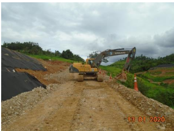
Foto 270 – Conformação de talude após chuva no bota fora VII, margem direita. (Data:13/01/20)
