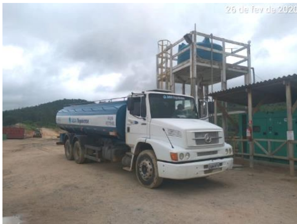
Foto 118 – Abastecimento de água no canteiro operacional. (Data:25/02/20)
