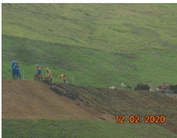
Foto 280 – Implantação de grama no talude da margem direita. (Data:12/02/20)
