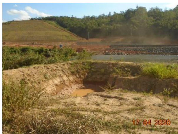
Foto 263 – Drenagem provisória na margem direita. (Data:17/04/20)
