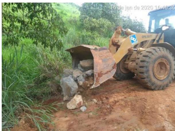
Foto 250 – Instalação de contenção na margem direita. (Data:16/01/20)
