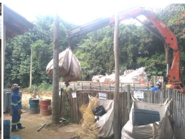
Foto 379 – Retirada dos resíduos recicláveis no canteiro administrativo. (Data:31/01/20)
