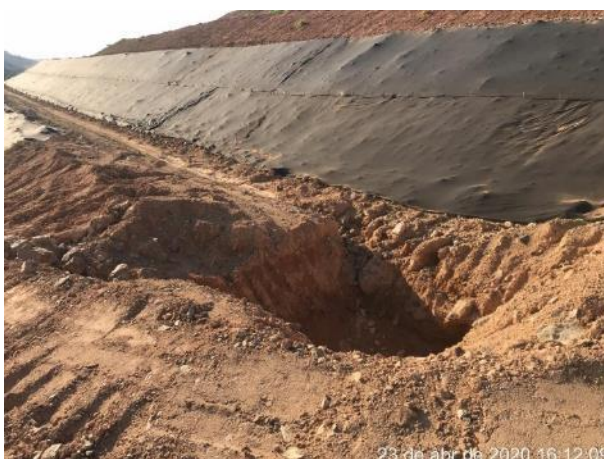
Foto 265 – Drenagem provisória do bota fora VII. (Data:23/04/20)
