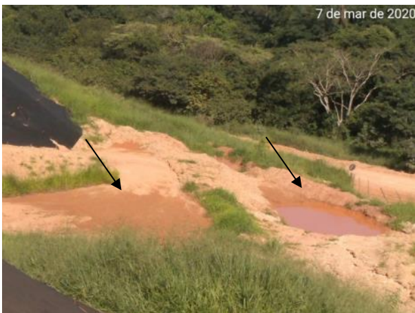
Foto 260 – Cacimbas no bota fora V, retendo a água das chuvas. (Data:07/03/20)
