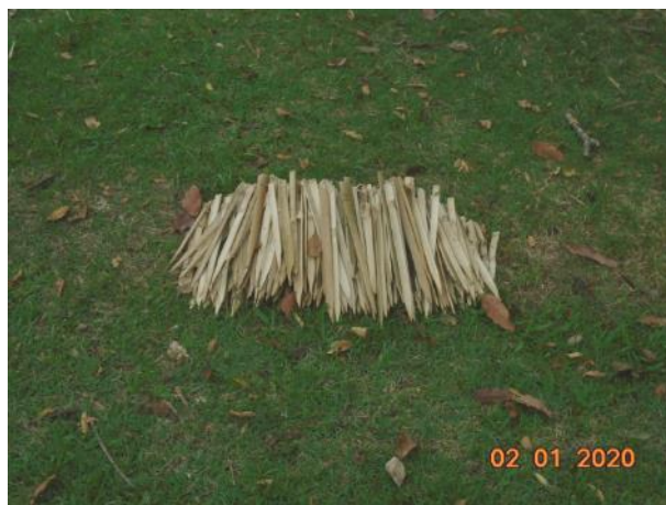
Foto 123 – Reutilização de bambu para fixação de manta geotêxtil em talude. (Data:01/01/20)
