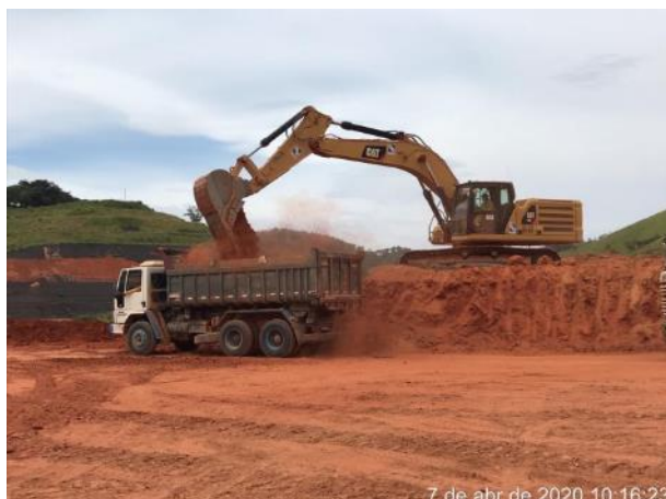
Foto 430 – Movimentação de terra na margem esquerda. (Data:07/04/20)
