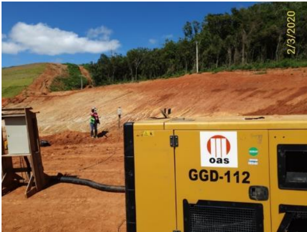
Foto 364 – Inspeção de fumaça preta em gerador. (Data:02/03/20)
