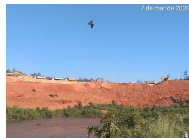
Foto 421 – Movimentação de terra na margem esquerda. (Data:07/03/20)
