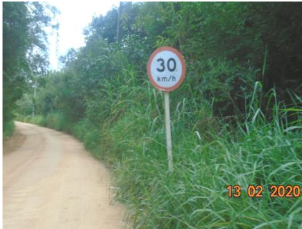
Foto 212 – Sinalização de limite máximo de velocidade no trecho, estrada sousas-pedreira. (Data:13/02/20)
