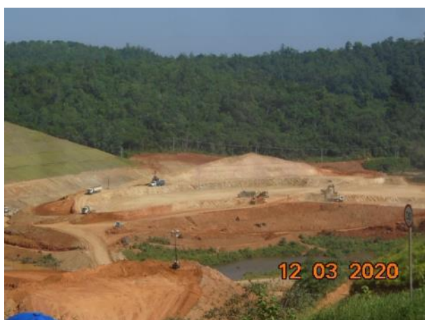
Foto 426 – Movimentação de terra – margem esquerda. (Data:12/03/20)
