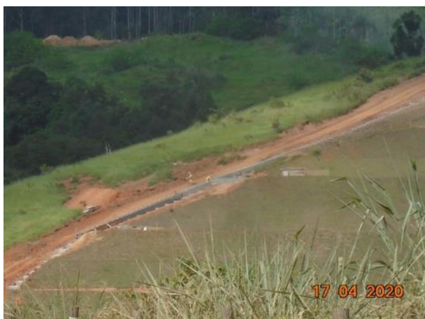
Foto 262 – Escada hidráulica – drenagem definitiva no talude de corte da margem direita. (Data:17/04/20)
