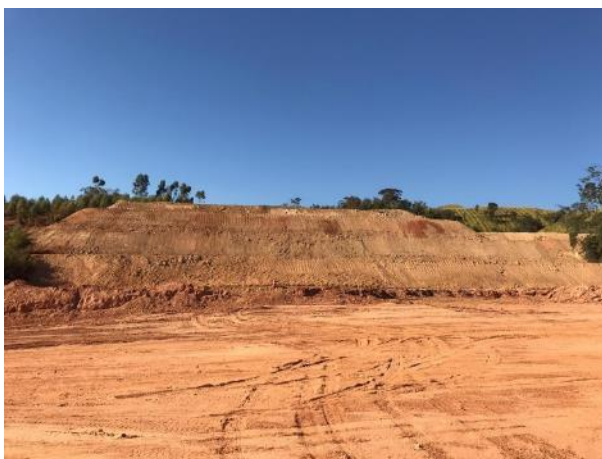
Foto 298 – Bota-fora II – Margem esquerda. (Data:30/04/20)
