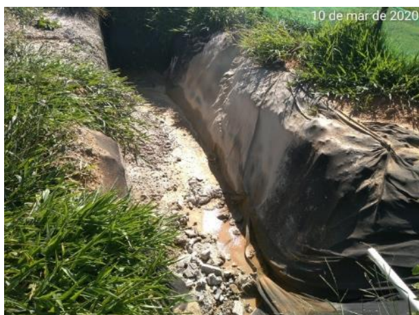
Foto 312 – Área para lavagem da calha de betoneira no canteiro operacional. (Data:10/03/20)
