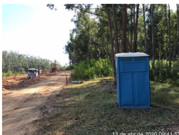
Foto 328 – Banheiro químico instalado na frente de serviço (Data:06/03/20)
