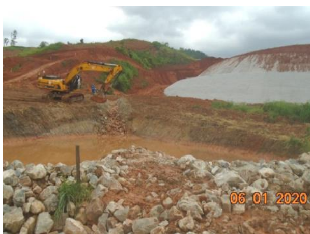
Foto 266 – Limpeza de cacimba na margem direita próximo ao eixo. (Data:06/01/20)
