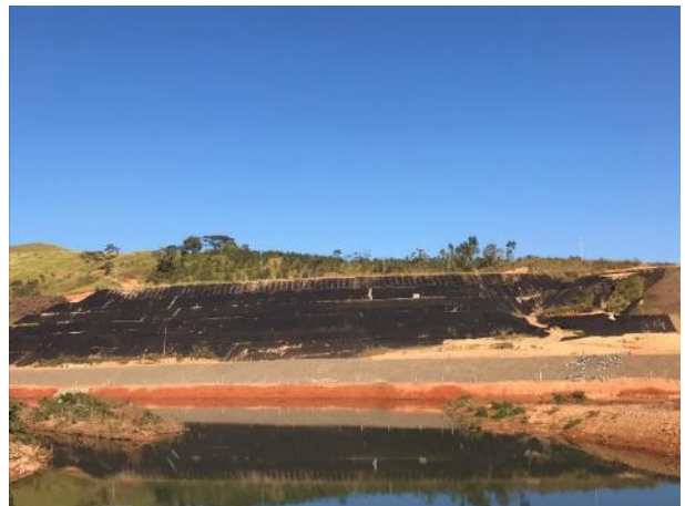
Foto 297 – Bota-fora I – Margem esquerda. (Data:30/04/20)
