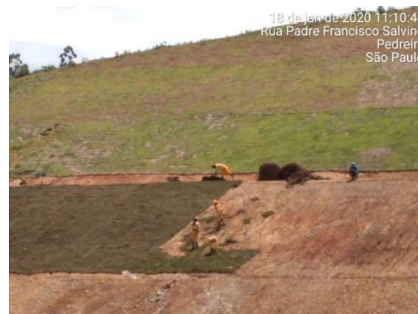
Foto 273 – Implantação de gama no talude de corte da margem esquerda. (Data:18/01/20)
