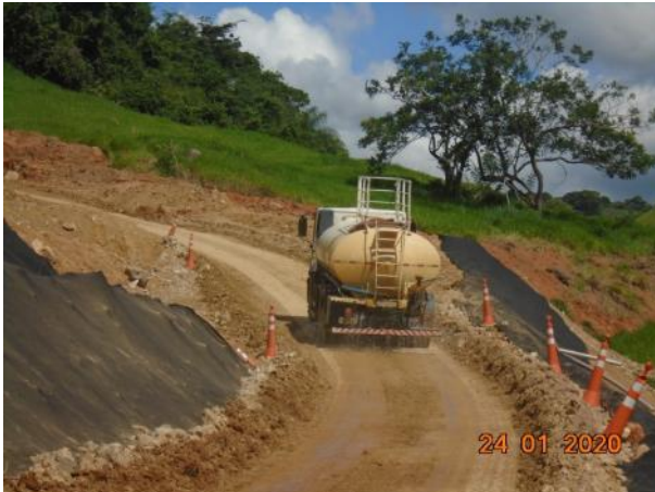
Foto 344 – Umectação nas vias internas – margem esquerda. (Data:24/01/20)
