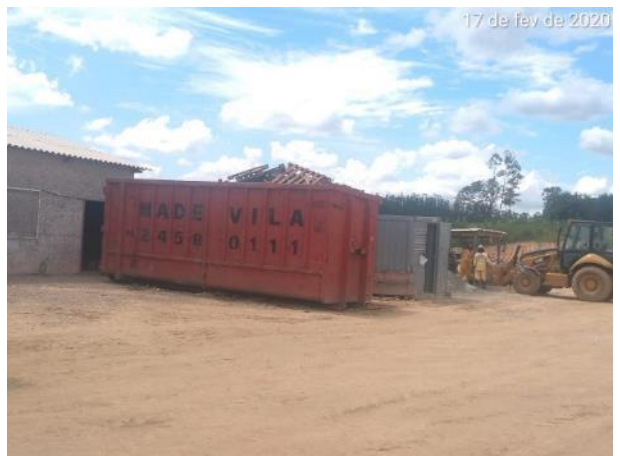
Foto 383 – Caçamba de resíduo de madeira no canteiro industrial. (Data:17/02/20)
