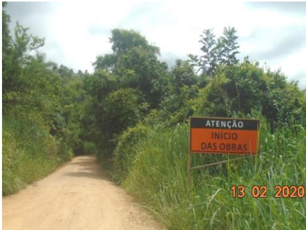
Foto 210 – Sinalização de início de obra, estrada Sousa-Pedreiras. (Data:13/02/20)
