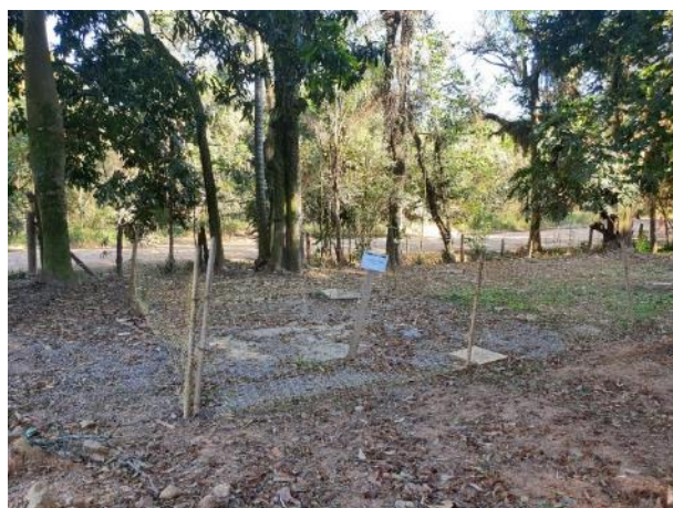
Foto 330 – Biodigestor 1 – canteiro administrativo. (Data: 17/04/20)
