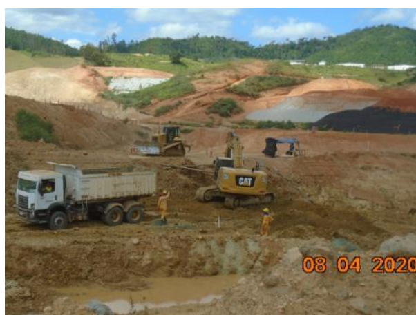
Foto 431 – Movimentação de terra na margem esquerda. (Data:08/04/20)
