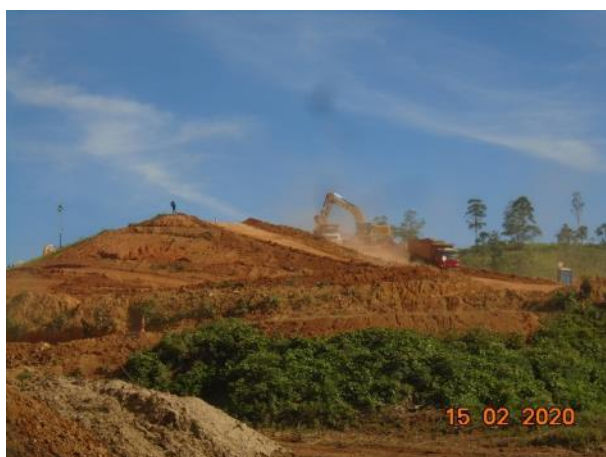
Foto 418 – Movimentação de terra na margem esquerda. (Data:15/02/20)
