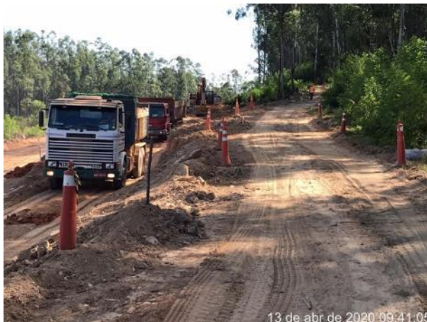
Foto 240 – Sinalização nas atividades do acesso da MD03. (Data:13/04/20)
