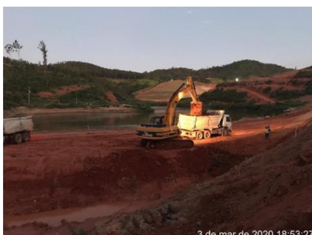
Foto 420 – Movimentação de terra na enseadeira J0, margem esquerda. (Data:03/03/20)
