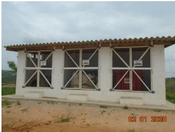
Foto 374 – Baía de resíduos instalada no canteiro operacional. (Data:02/01/20)
