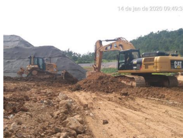
Foto 395 – Movimentação de terra no acesso ao bota fora VII. (Data:14/01/20)
