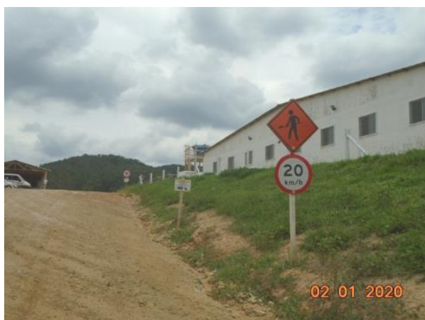
Foto 228 – Sinalização de velocidade máxima permitida, e de homens trabalhando. (Data:02/01/20)
