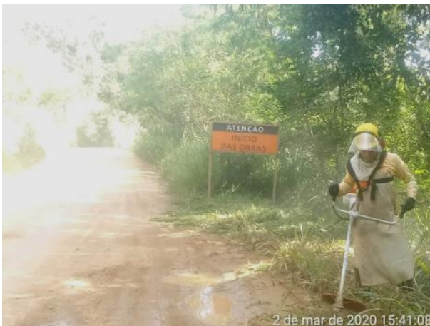
Foto 214 – Manutenção próxima a via. (Data:02/03/20)
