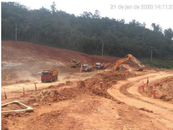
Foto 402 –Movimentação de terra na margem esquerda. (Data:21/01/20)
