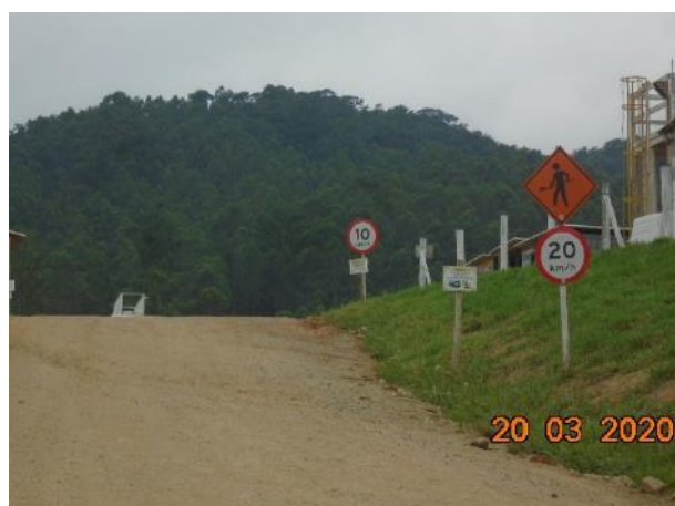
Foto 237 – Sinalização interna para redução de velocidade no canteiro operacional. (Data:19/03/20)
