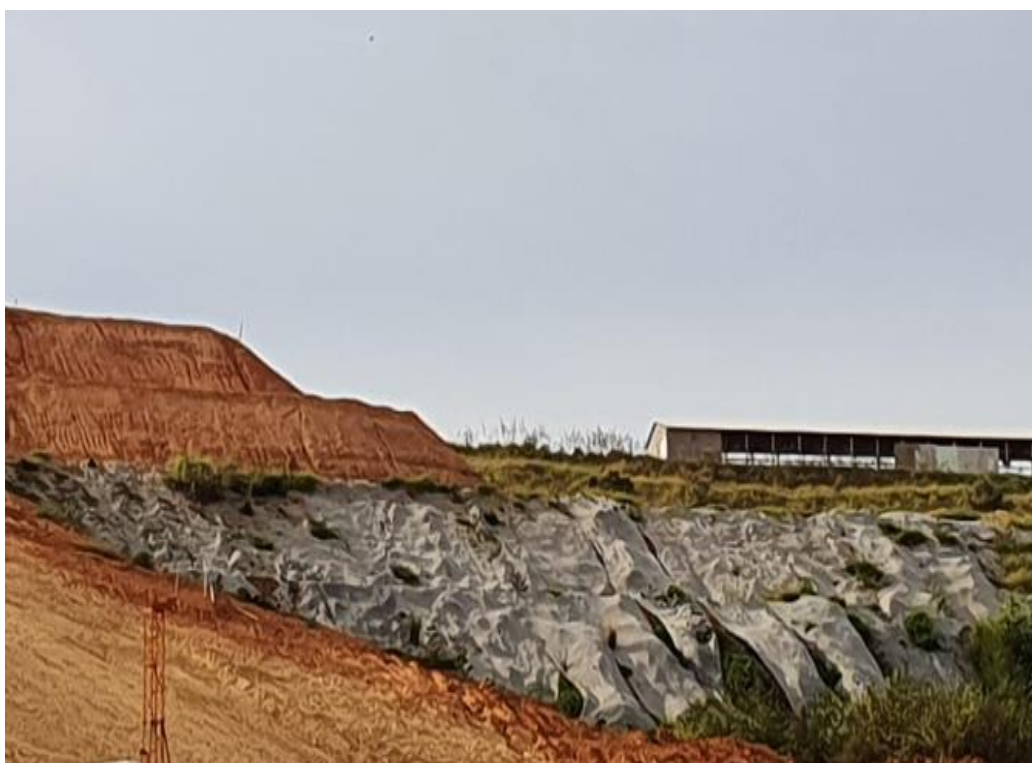
Foto 439 – Bota fora II – Margem Direita. (Data:30/04/20)
