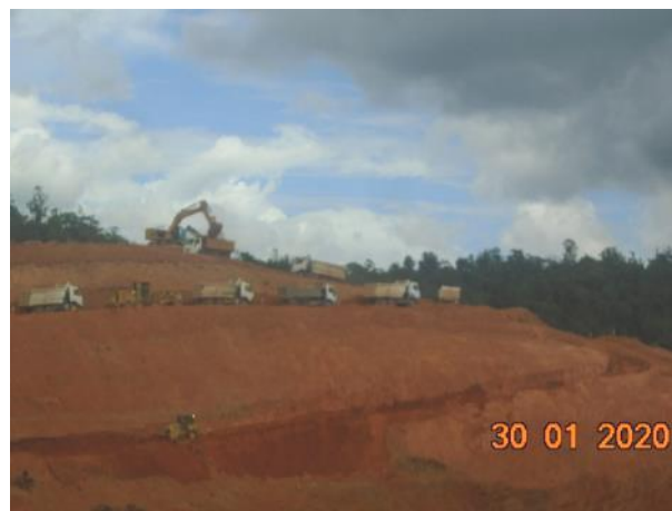
Foto 409 – Movimentação de terra próxima a área do eixo na margem esquerda. (Data:30/01/20)
