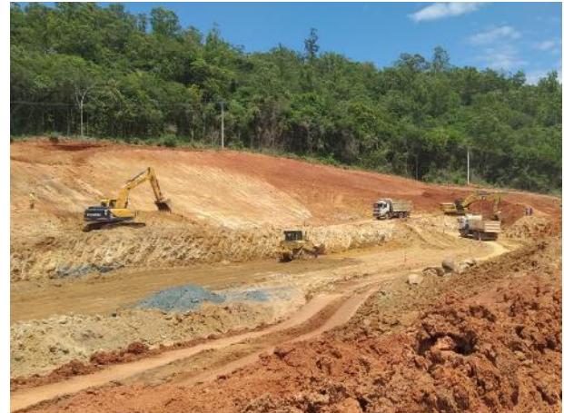
Foto 399 – Movimentação de terra na área do desvio do rio, margem esquerda. (Data:26/12/19)
